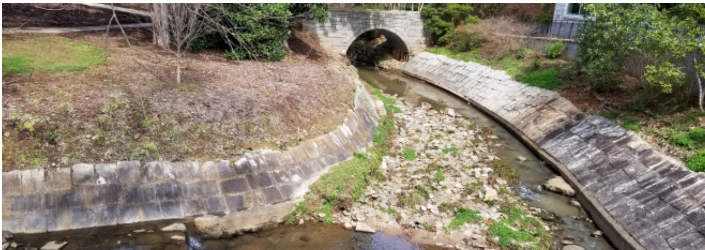
Tanyard branch est canalisé sur la majorité du tronçon, ce qui le rend semblable à une conduite d'eau pluviale.
